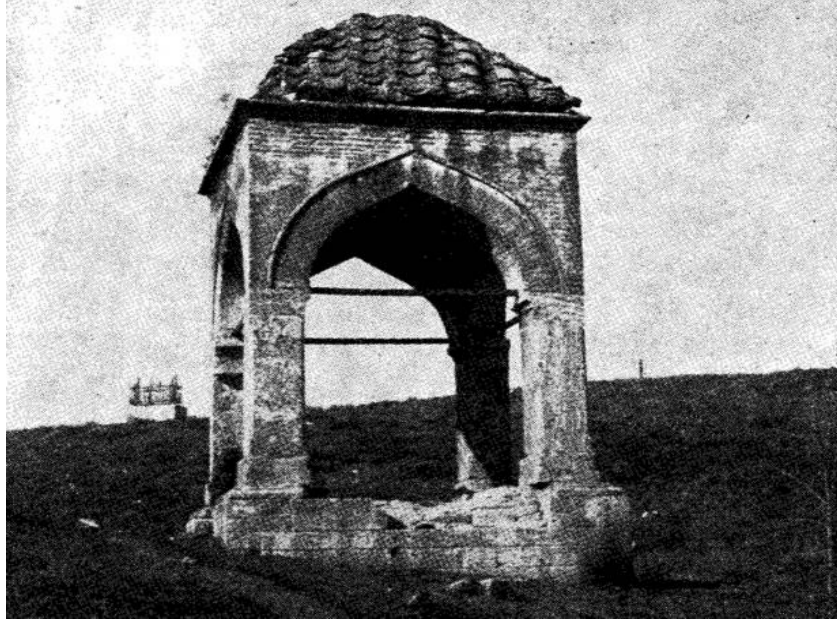
Resim 1. Türbe'nin 1963 yılındaki depremde yıkılmadan önceki hâli
