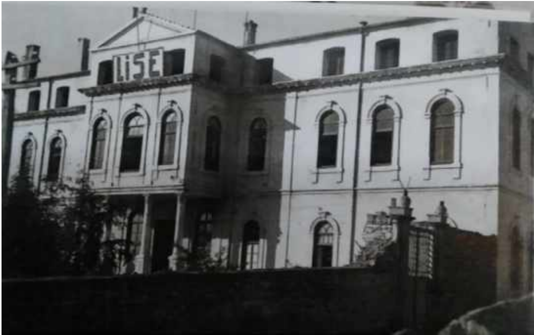
F23. Ön cephe, bahçe kapısı ve duvarı (Balıkesir Liseliler Derneği Arşivi).
