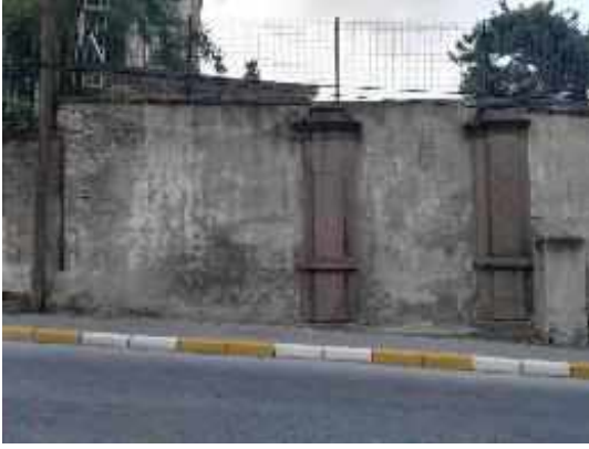
F14. Ali Hikmet Paşa Caddesi yönündeki kapatılmış bahçe kapısı.
