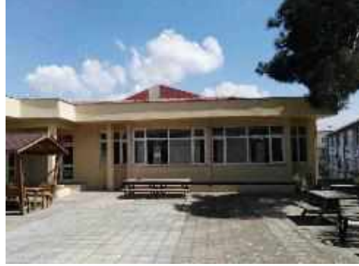
F15. Ön bahçe de yer alan betonarme kantin binası.
