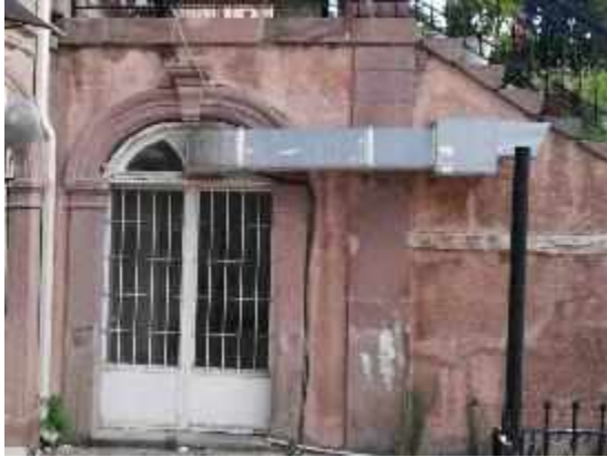
F6. Giriş merdiveni altında bodruma açılan kapı.
