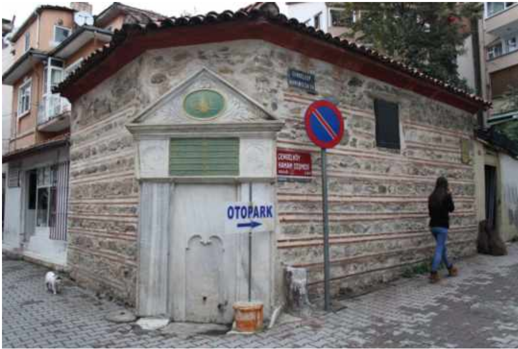
Foto.14: Yusuf Ziya Paşa Çeşmesi Genel Görünüş
