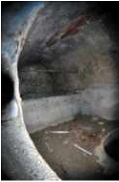
Fotoğraf: 25 Su deposunun güneyi ve batı duvarındaki soğuk su deposu (2015).
