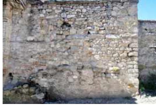
Fotođraf: 39 Hamamın kuzey duvarı, ana giriş kapısının batısı. (Kapı bitiřiđindeki tamirat izleri, yeni tuđla ile ahřap hatıl kullanımı burada açıkça görölmektedir) (2015).
