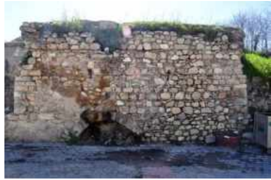
Fotoğraf: 27 Hamamın batı cephesindeki külhanın girişi (2015).
