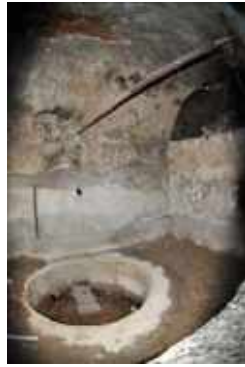
Fotoğraf: 26 Su deposunun kuzeyi. Depo zeminindeki bakır kazan yuvası (2015).
