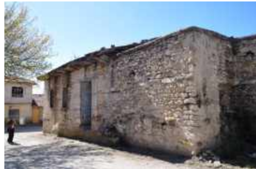
Fotoğraf: 37 Hamamın kuzey dış duvarı (2015).
