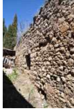
Fotoğraf: 32 Yıkık mekânları çeviren hamamın güney dış duvarı (2015).
